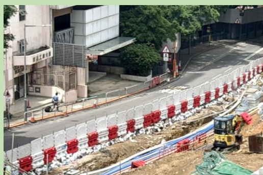
建造停車灣 Bus Lay-by Construction
