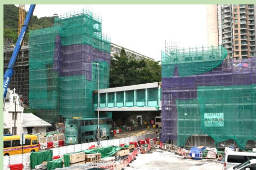
行人天橋工程 Footbridge Construction
