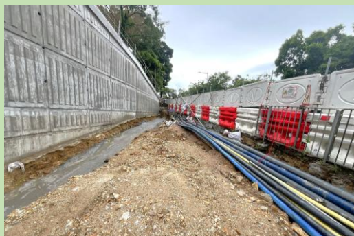
地下管線改道工程 Utility Diversion Works
